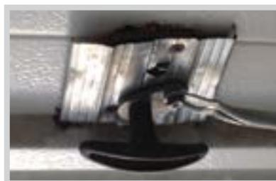
Прочности панели недостаточно для надежного крепления к ней замка и ручки. Приложенные дополнительные усилия для открытия ворот (например, зимой) могут привести к деформации как ручки, так и самой панели.
