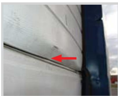
Деформация панелей на стыке, полученная при силовом открывании ворот, с обледенением в зоне защиты от защемления пальцев. Межпанельный уплотнитель нижней панели выдавлен верхней сэндвич-панелью
