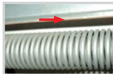
Уплотнитель становится хрупким от атмосферных воздействий и разрушается. Горизонтальный «гофр» нарушает герметичность ворот. На торцах направляющих отсутствует цинковое покрытие, и металл быстро ржавеет.
