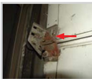
Внутренняя сторона показанного выше стыка. Петля была деформирована и вырвана из нижней панели. Для ее закрепления панель просверлена насквозь выше первоначальной точки крепления
