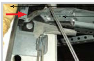
Применение непрочного пластика для изгибов направляющих приводит к его быстрому износу и поломке. Промерзание холодной угловой стойки приводит заказчика к необходимости ее утепления монтажной пеной.
